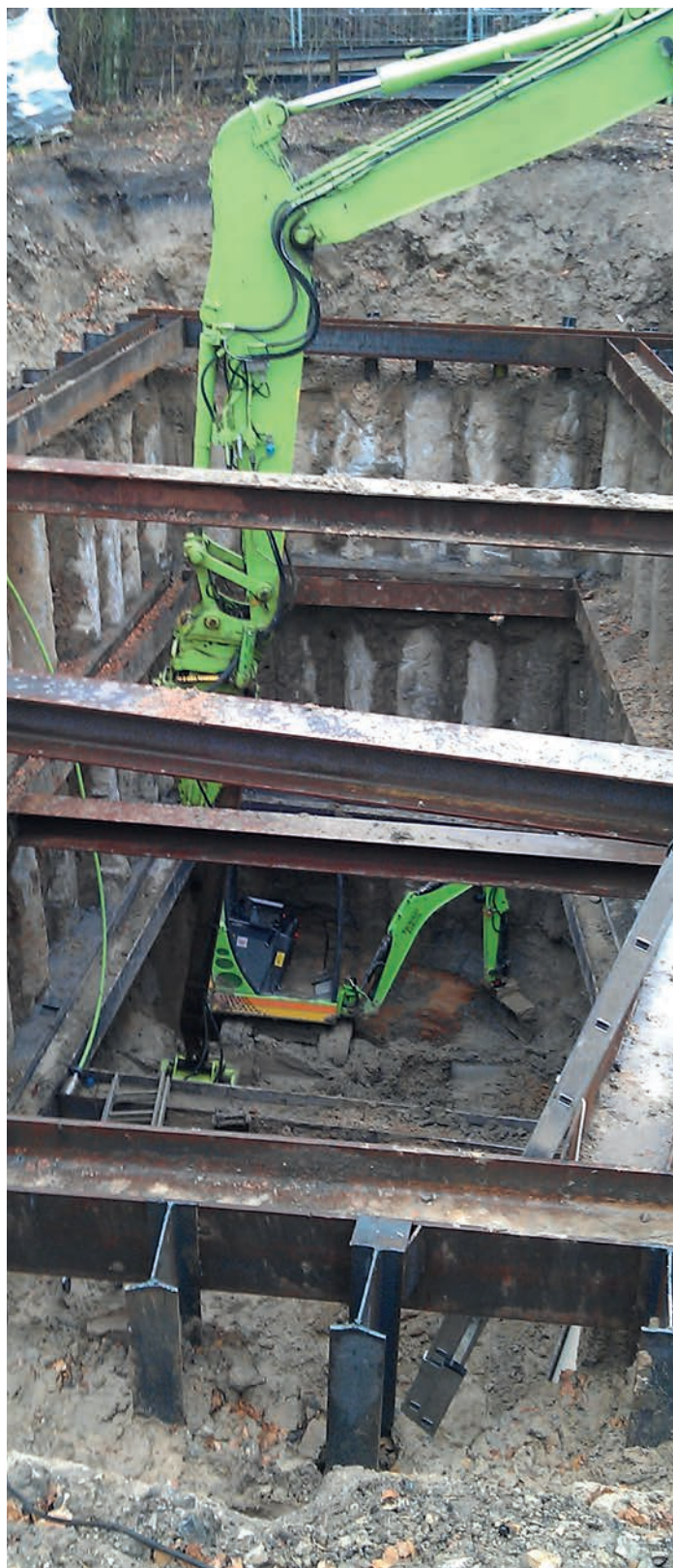
Opgravning af kraftig jordforurening med klorerede opløsningsmidler i Faaborg-Midtfyn Kommune. Forureningen stammer fra et tidligere renseri på ejendommen. Der blev gravet til 12,5 meter under jordoverfladen. Oprensningen skal sikre betydningsfuldt drikkevand.
